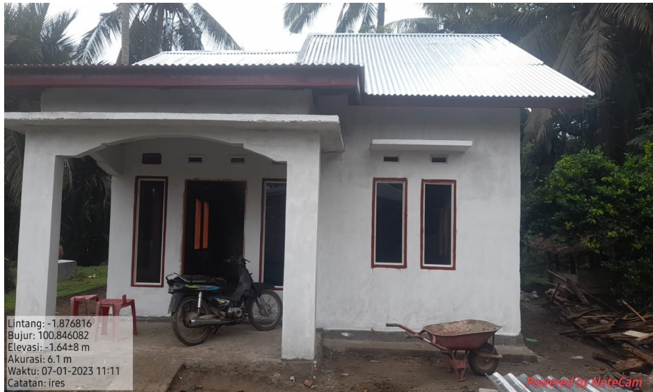
Rumah Layak Huni (Setelah di rehabilitasi)
