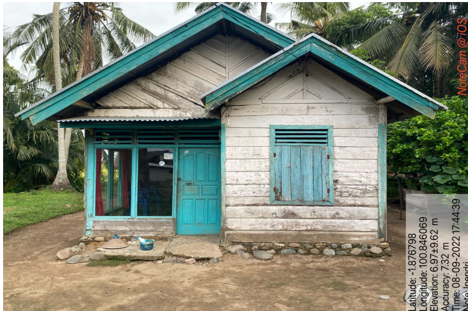
Rumah Tidak Layak Huni (Sebelum di rehabilitasi)
